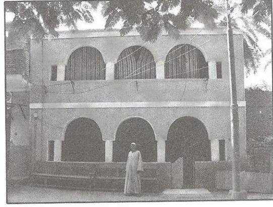
شكل (٤٠) مضييفة بعقود تقع بمنطقة وش الدار وتستخدم فيها الدكك الخشبية، والباب بمقدمة المضييفة
