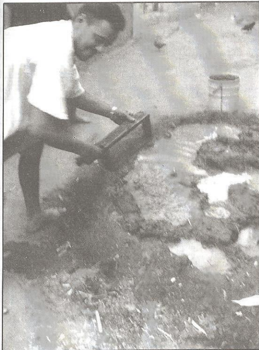
شكل (١١) ملء القالب من المعجنة لعمل الطوب
