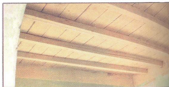
استخدام العروق والألواح في السقف الخشبي
