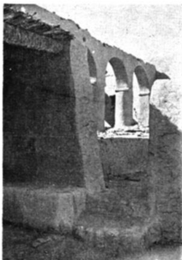
مدخل المضييفة بلا باب وحجرة الاستقبال الخارجية المسقوفة بجذوع النخيل والجريد وتبدو بداخلها المصطبة
