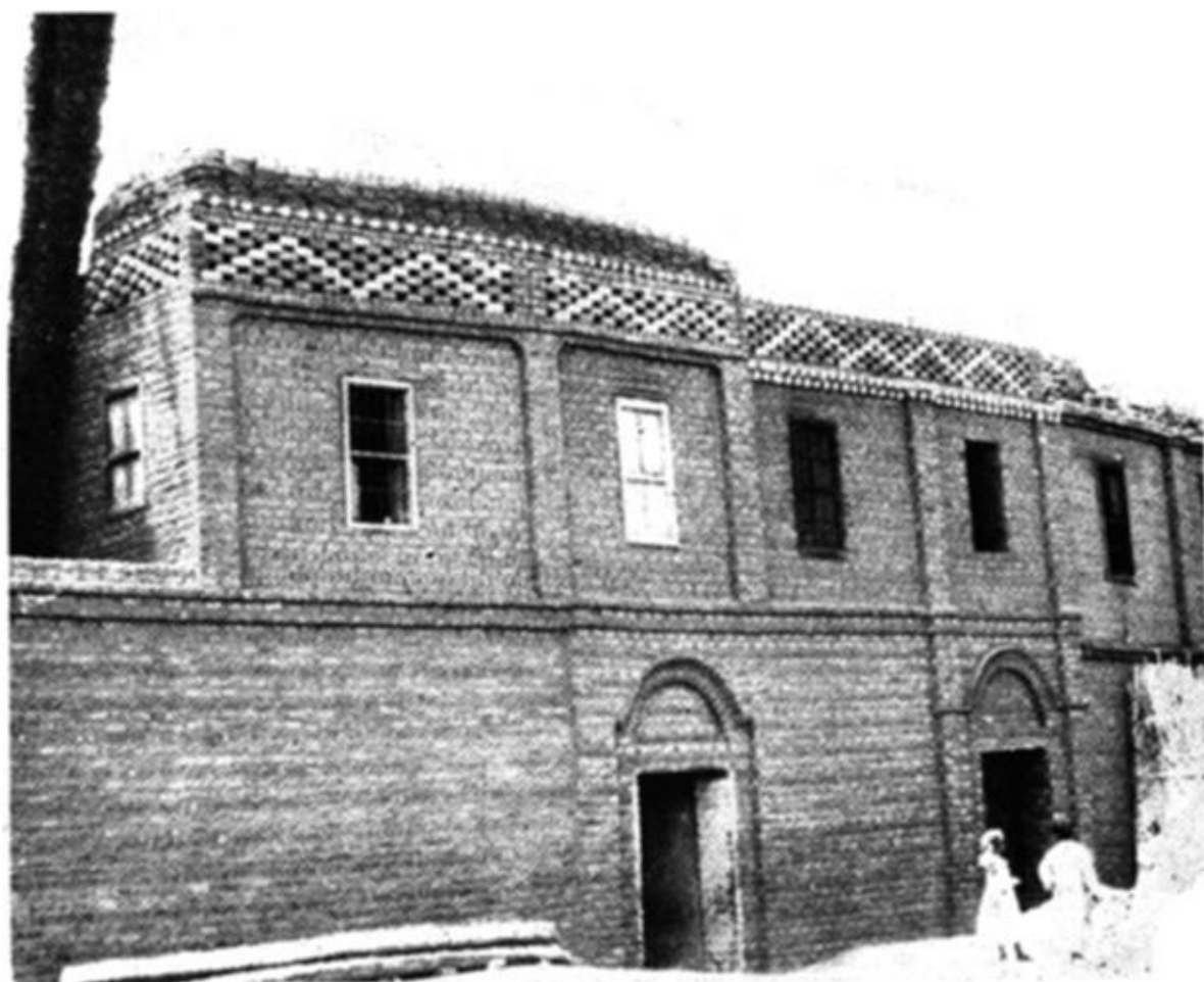
مبانى العرابة المدفونة حيث يظهر بوضوح استخدام قوالب الأجر فى عمل الوحدات الزخرفية الهندسية
