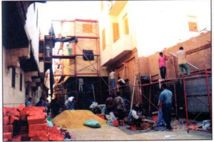
ترميم واجهات المنازل
